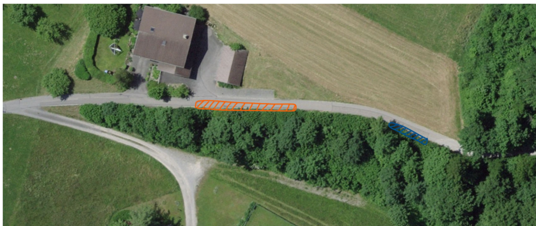
Abb.: Schulhausstrasse 7 / 7a (Orange: sanierungsbedürftiger Abschnitt / Blau: Hangrutsch)
