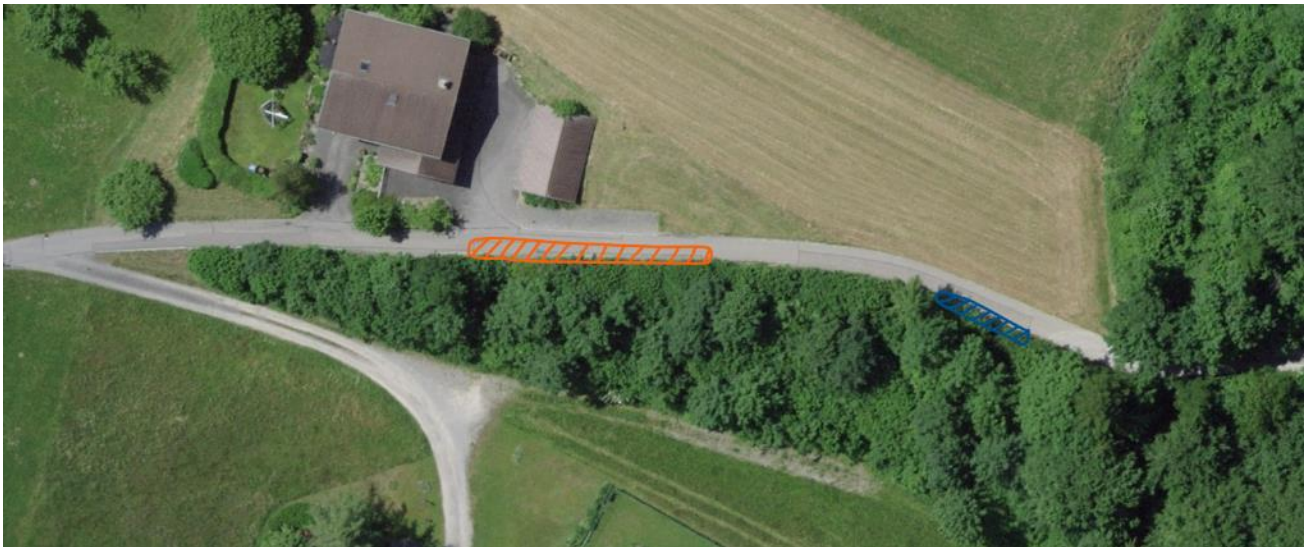
Abbildung 1 Schulhausstrasse 7 / 7a (Orange: sanierungsbedürftiger Abschnitt / Blau: Hangrutsch)
