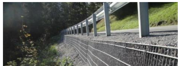
Abbildung 2 Bankettsicherung mit Geogitter (z.B. SYTEC BaFix S)
