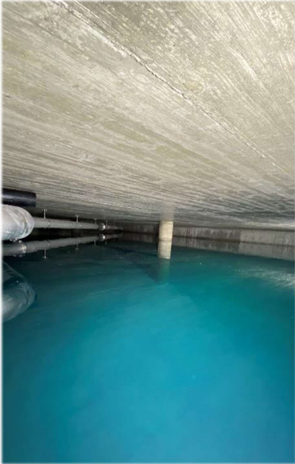
Blick in eine neue Reservoirkammer
