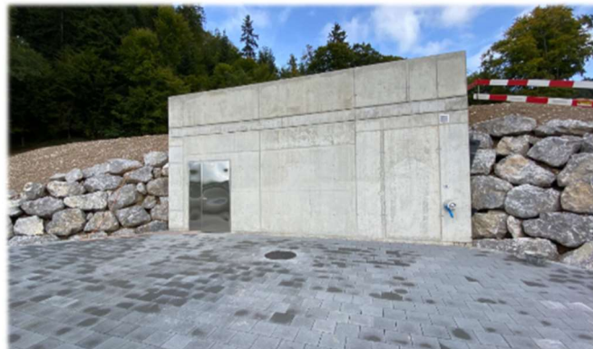
Aussenansicht des neuen Reservoirs
