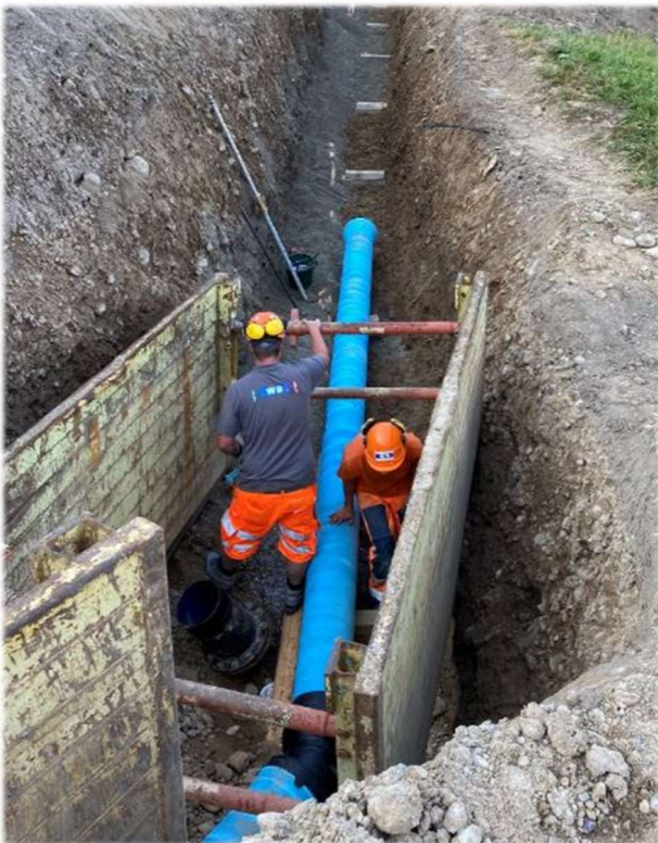
Rohleitungsbau DN 250 aus Duktulgussrohren mit Zementmörtel-Umhüllung (Wild AG)
