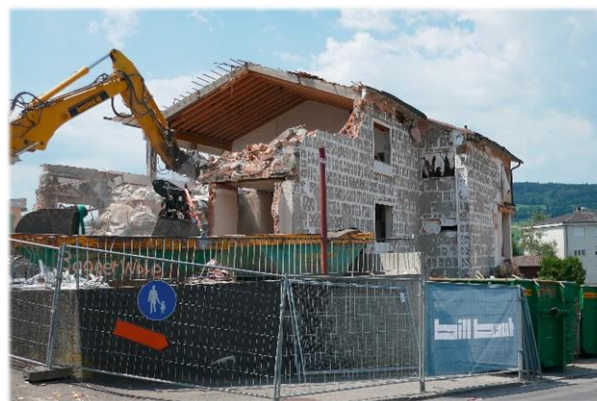
Abbrucharbeiten am alten Schulgebäude
