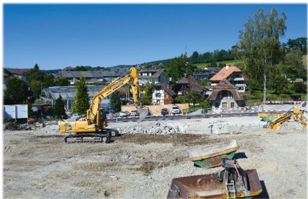
.. die Vorbereitungen für den Neubau sind auf Kurs
